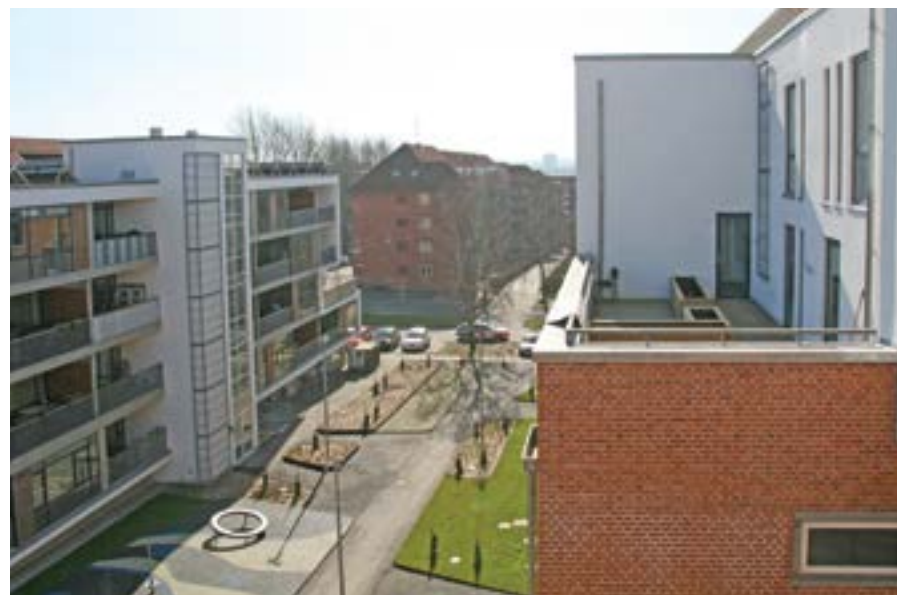
Udsigten fra tagterrassen til gårdmiljøet og til naboterrassen, som giver adgang til den hængende lejlighed.
