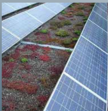
ELEMENTER TIL ENERGIPRODUKTION OG SKYBRUDSIKRING I SAMME TAGLØSNING
