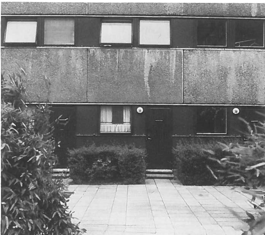
Facadeudsnit mod gården, med indgange til de beskyttede boliger.
