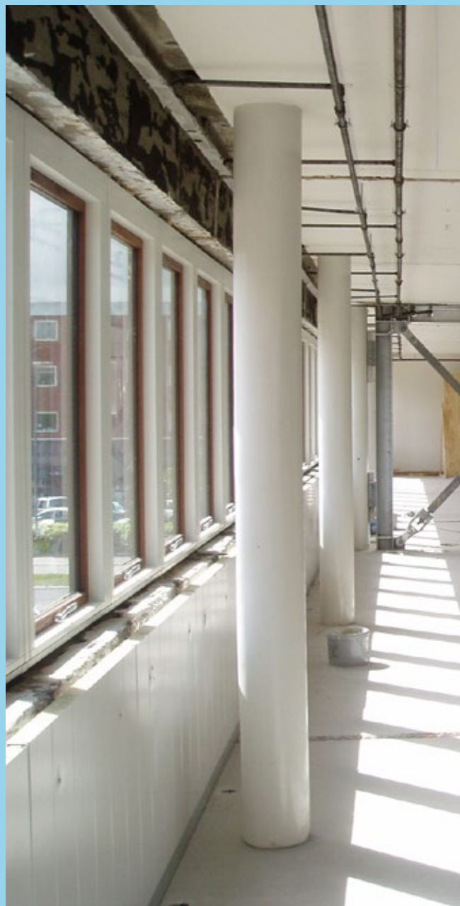
Efterisolering under vinduerne
