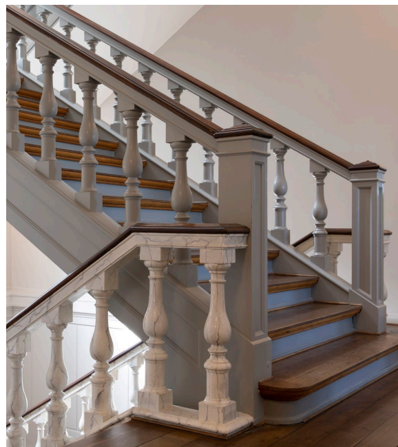
Mødet mellem de to trappeløb - 1868 og 1940
