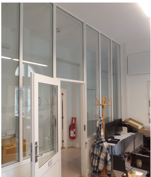
Stueetagen i Visitationsbygningen før ombygning med glasskillevægge
