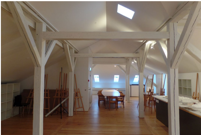
Tagetagen i Visitationsbygningen før ombygning
