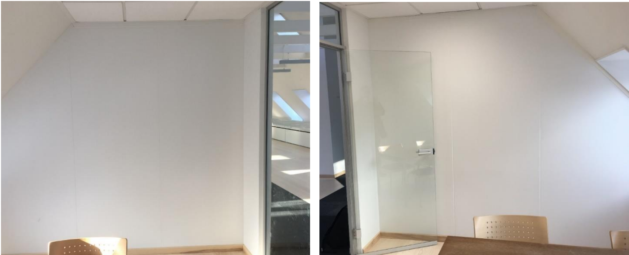
Gipsskillevægge set med normal belysning til venstre og med lys langs med væggen til højre, så samlinger bliver meget synlige
