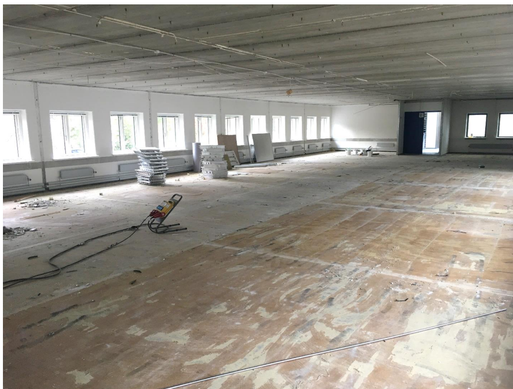
1. salen efter nedrivning af eksisterende skillevægge
