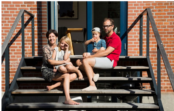
Med en ny bred havetrappe i stål og en dobbeltdør fra køkkenalrummet ud til trappen er haven for alvor bragt i spil. Trappens lette stålkonstruktion er meget moderne i forhold til muremestervillaen, men omvendt udformet så transparent som muligt med få lodrette og vandrette stålstænger, at den ikke tager fokus fra huset.
