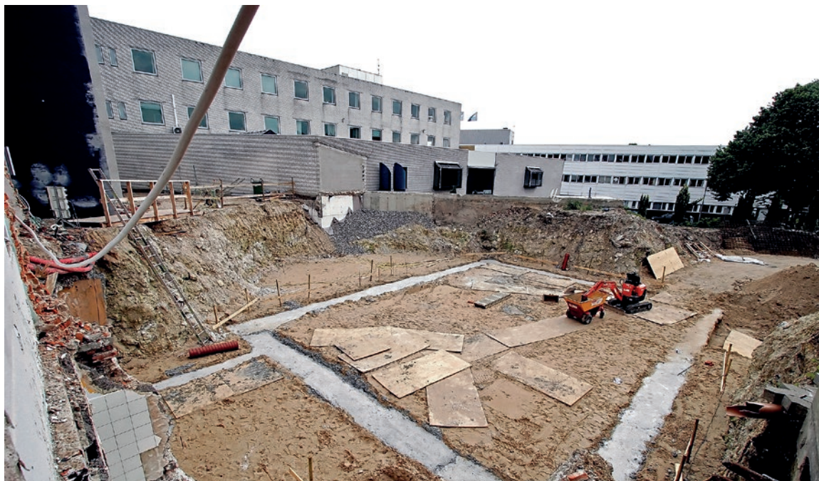
Udgravning bag den gamle avisbygning i sommeren 2007, hvor trykkeribygningen hidtil havde stået. Fundamentet til den nye kontorblok er lagt. (Klaus Madsen)
