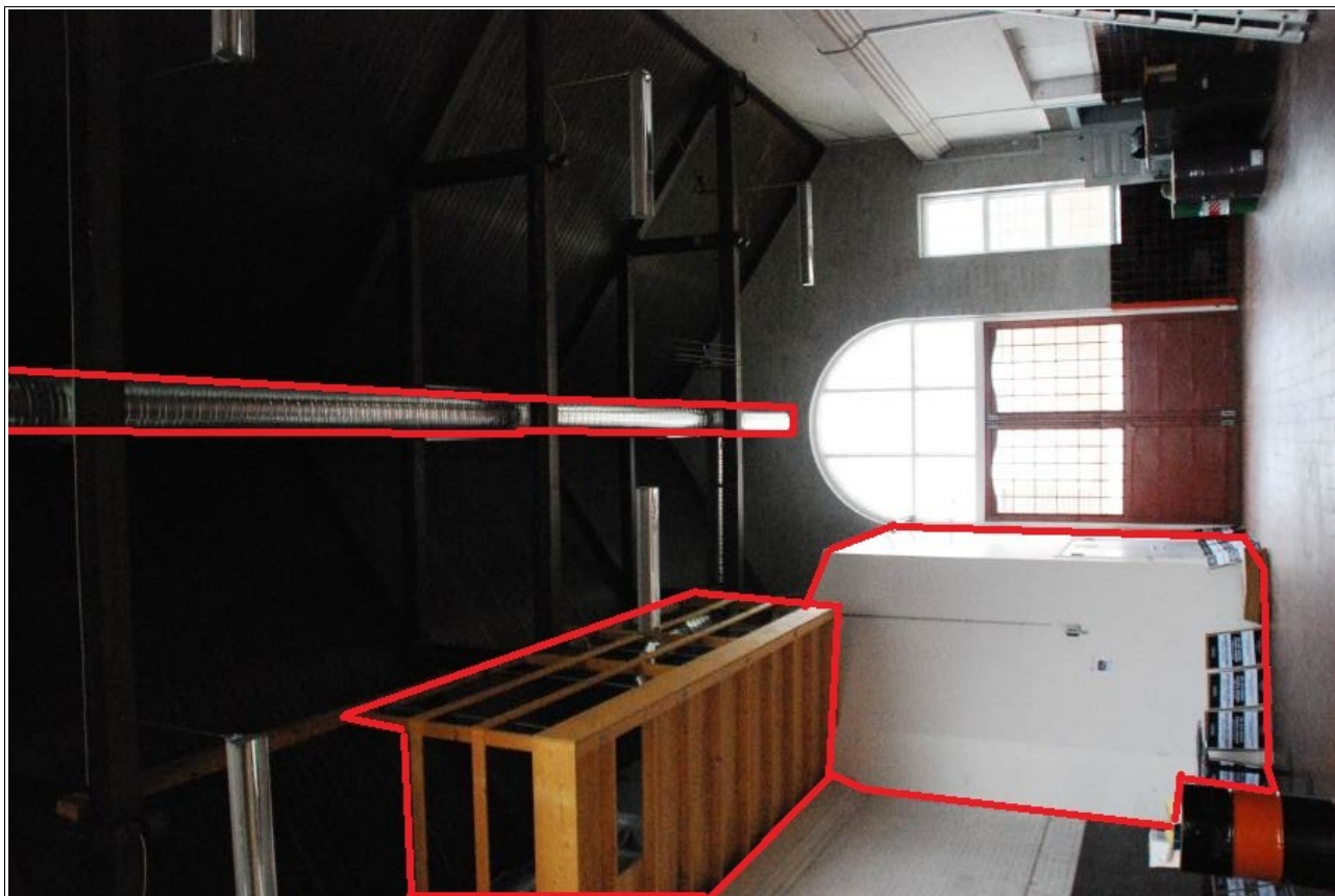
Billede 3_3: Elementer som fjernes i koncertsal markeret med rødt. Rummet står herefter rektangulært, og uden forstyrrende elementer i tagkonstruktionen
