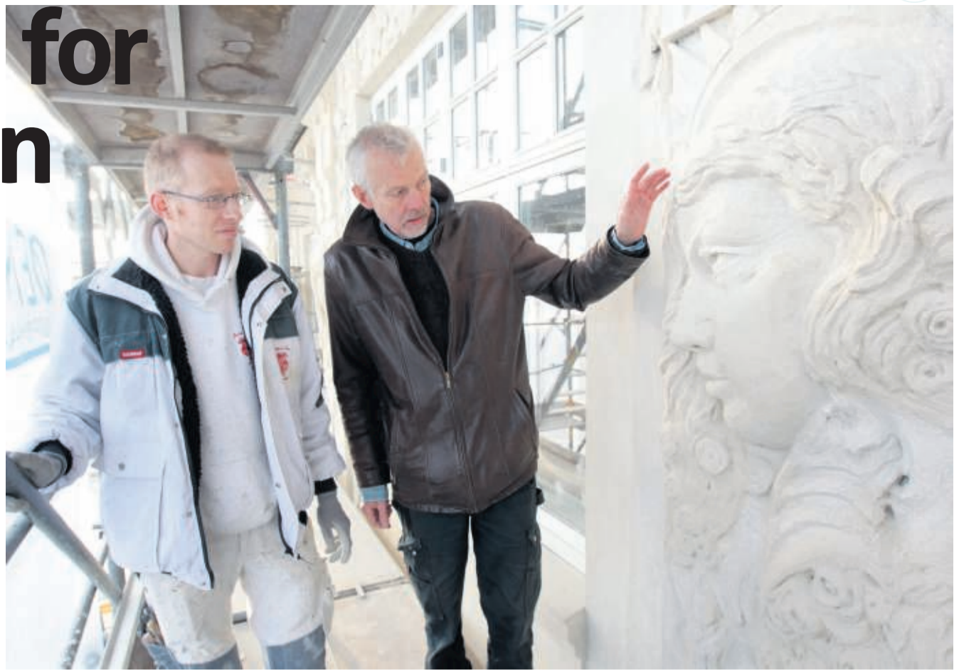
Stukkator og billedhugger Ole Lorin Rasmussen står for det detaljerende arbejde med at lave stukken på ejendommen på Frederiksberg Allé. Her er han oppe på stilladset med beboer Søren Ankarfeldt. Foto: Martin Sørensen
