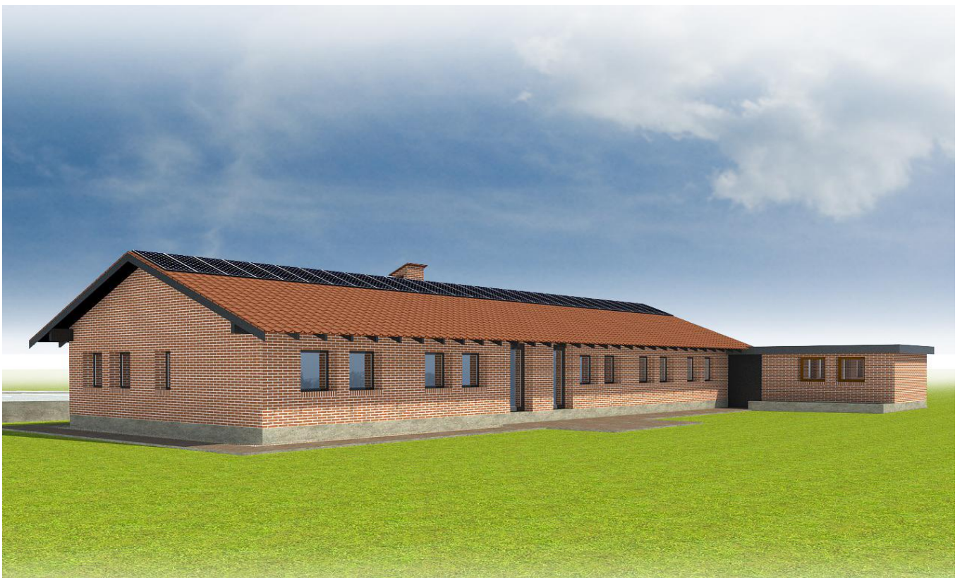
Sydfacade med tagintegreerede solceller langs rygning.
