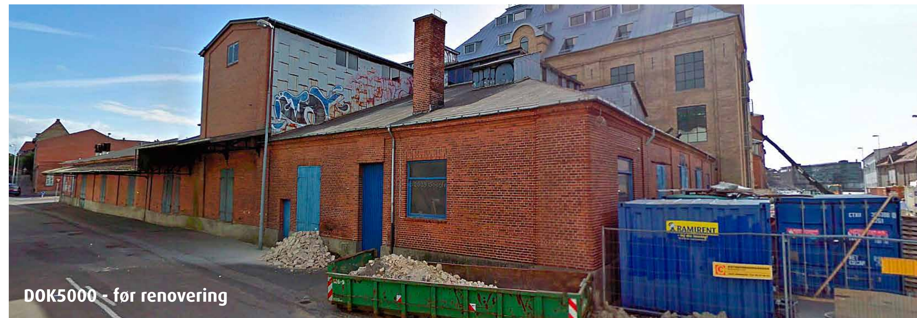
DOK5000 - set fra Sverigesgade/Helsingborggade
