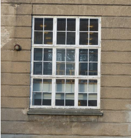
Vinduesparti før renoveringen
