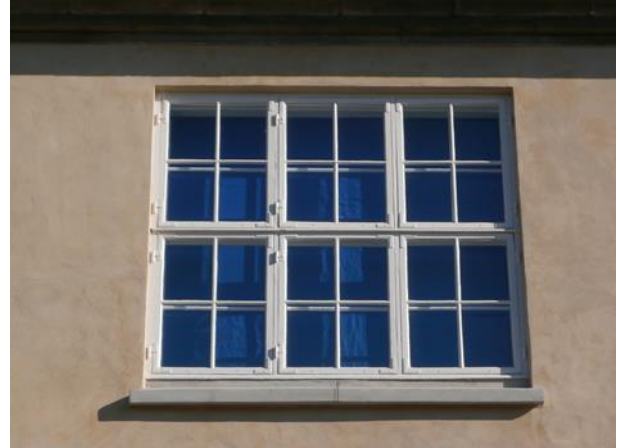
Vinduesparti efter renoveringen
