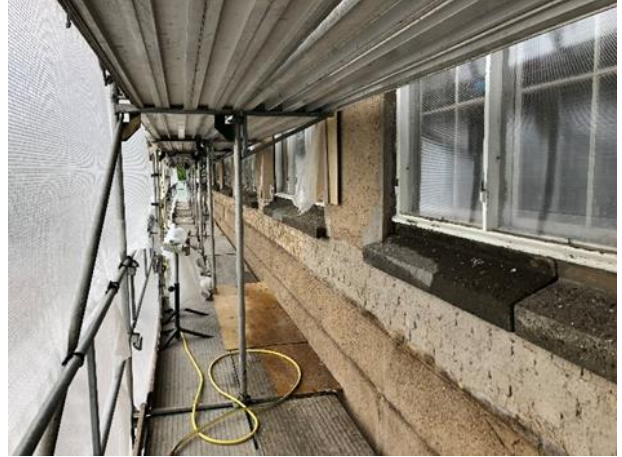
Udkastning af grundingsmørtel
