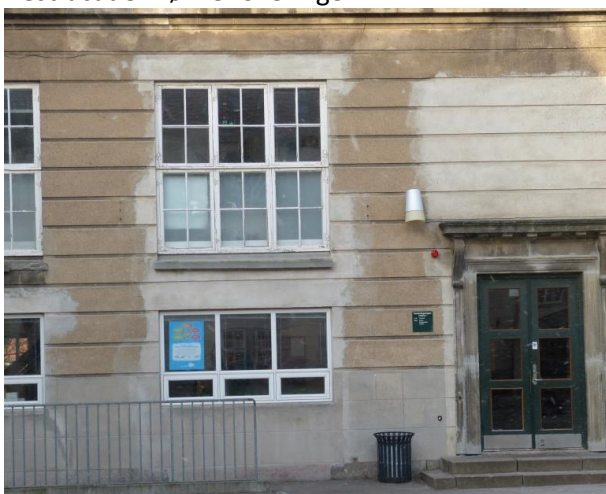
Facadeudsnit før renoveringen
