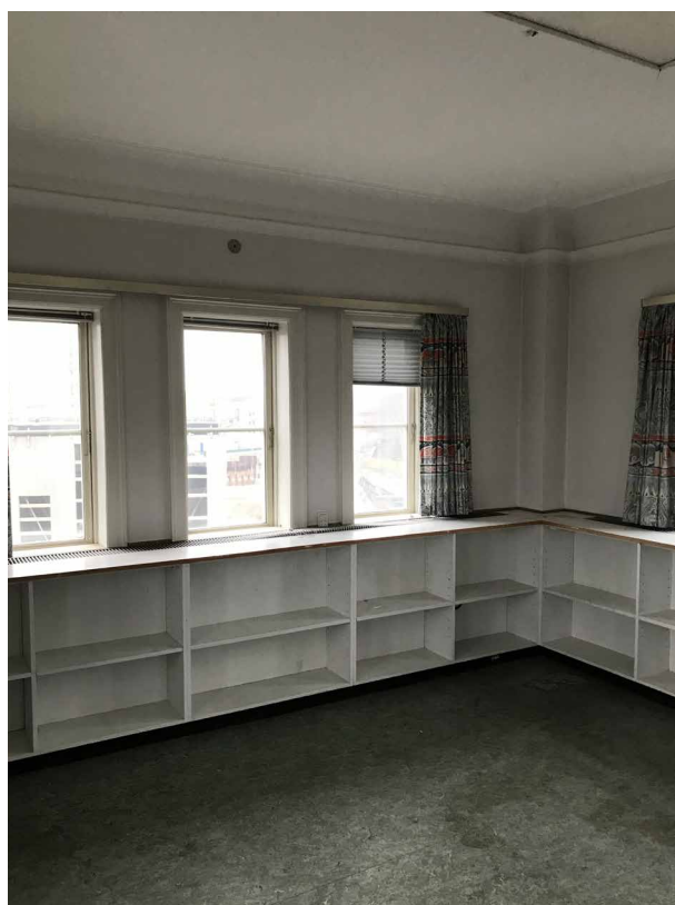
E.3.11 Nyere reolsystem, linoleumsgulv, pudset loft med stuk og inspektionslem til tag.
