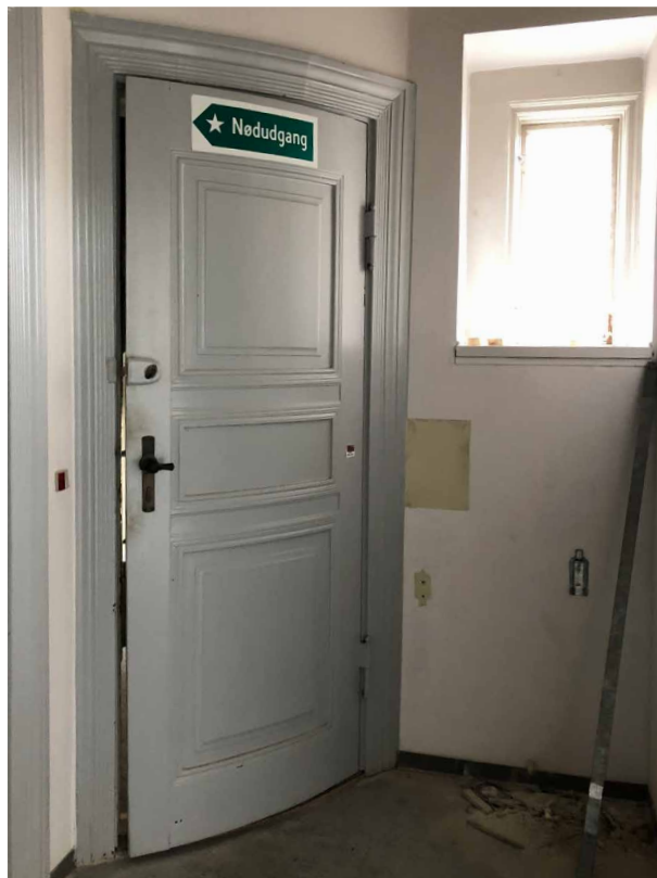
E.1.06 Krum fyldningsdør til granitspindeltrappe mod nord.
