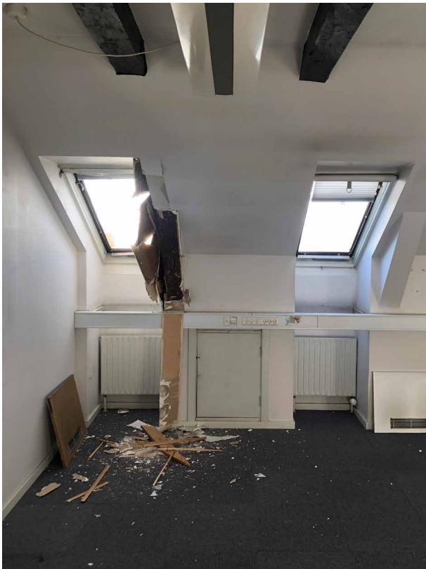
E.2.18 Højtplacerede nyere tagvinduer, gulvtæppe og trempel-/skråbenskonstruktion beklædt med gips.
