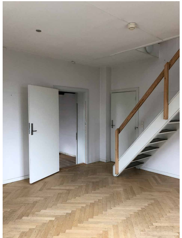
E.2.16 Nyere parketgulv, pudset loft og nyere trappe mellem 2. og 3 sal.
