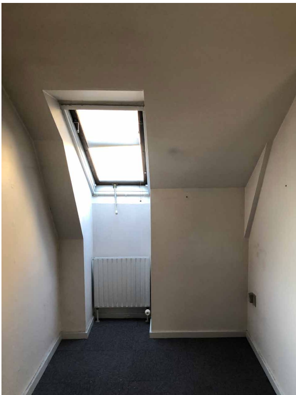
E.2.14 Højtplacerede nyere tagvinduer, gulvtæppe og trempel-/skråbenskonstruktion beklædt med gips.
