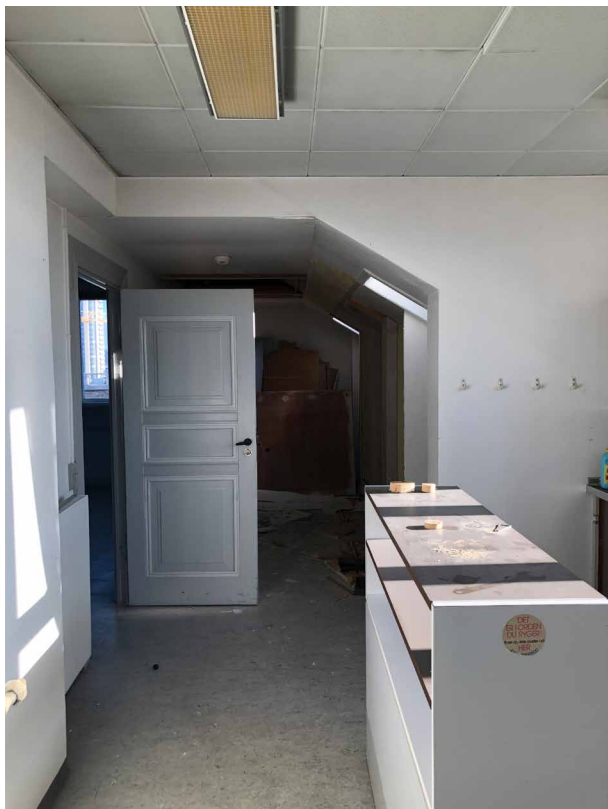
E.3.03 Linoleumsgulv, nyere køkken, nedsænket systemloft, gipsbeklædning på spær-/tagkonstruktion og fyldningsdør.
