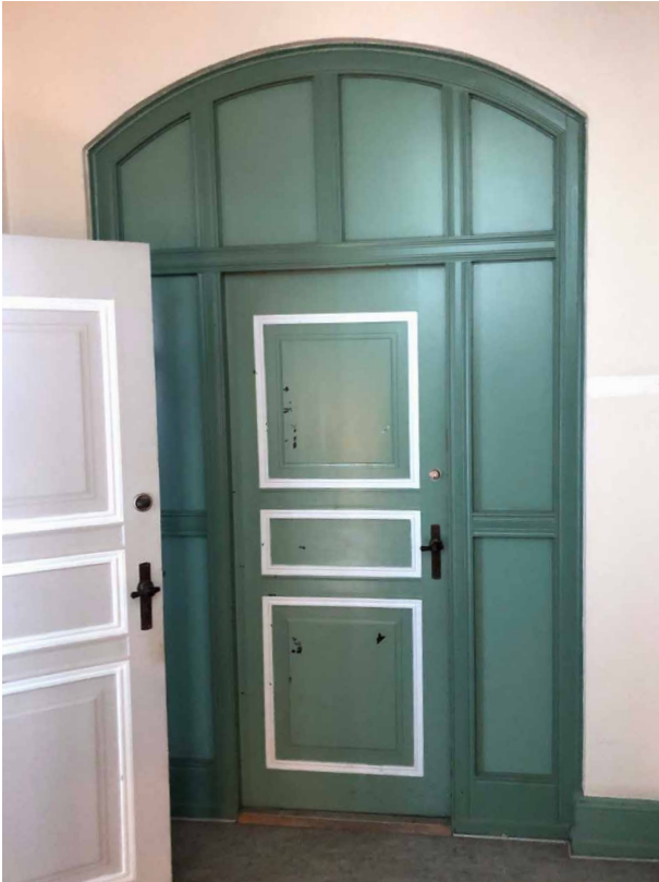
E.1.12 Fyldningsdører og panelvæg ved repos trapperum i nordfløj.
