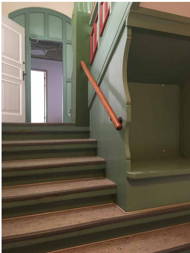
E.1.12 Oprindelig trappe beklædt med linoleum
