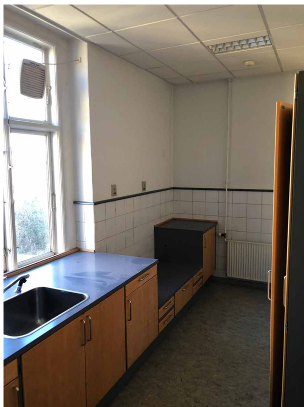
E.2.01 Nyere køkken, nedhængt systemloft og linoleumsgulv.
