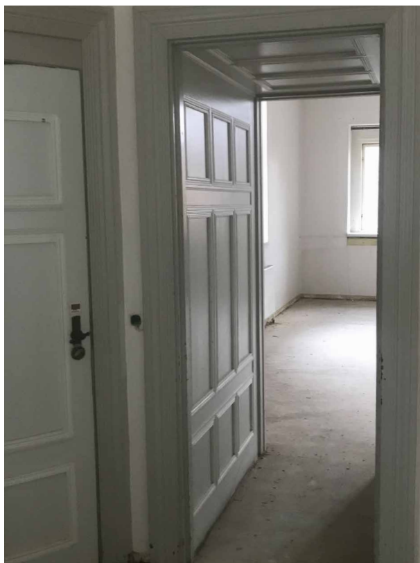
E.0.05 Panelbeklædt dørlysning gennem skorstens-/ventilationskerne og krum fyldningsdør mod granitspindeltrappe.
