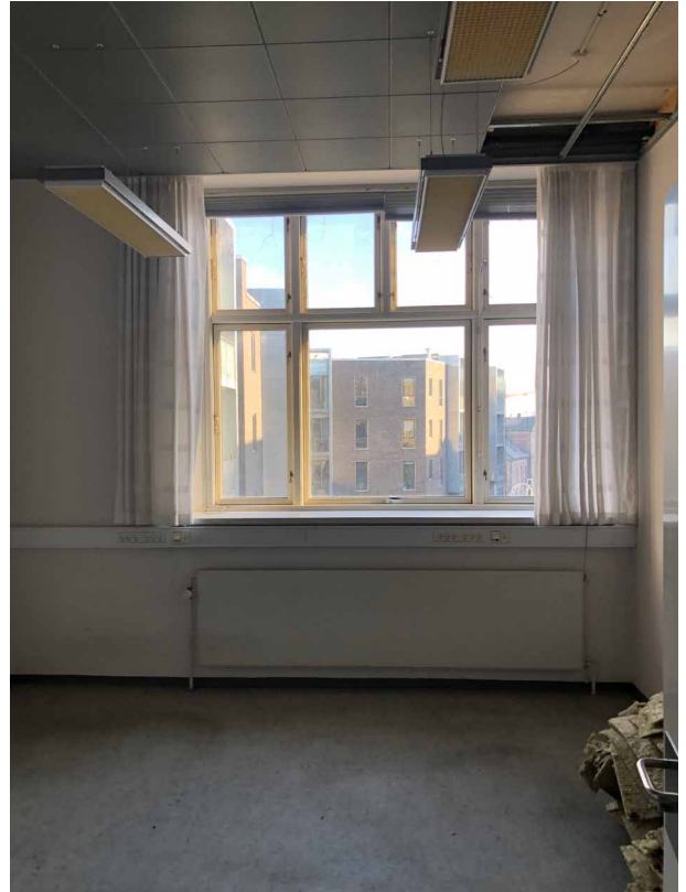
E.1.03 Nedhængt systemloft, linoleumsgulv og kabelbakke i væg.
