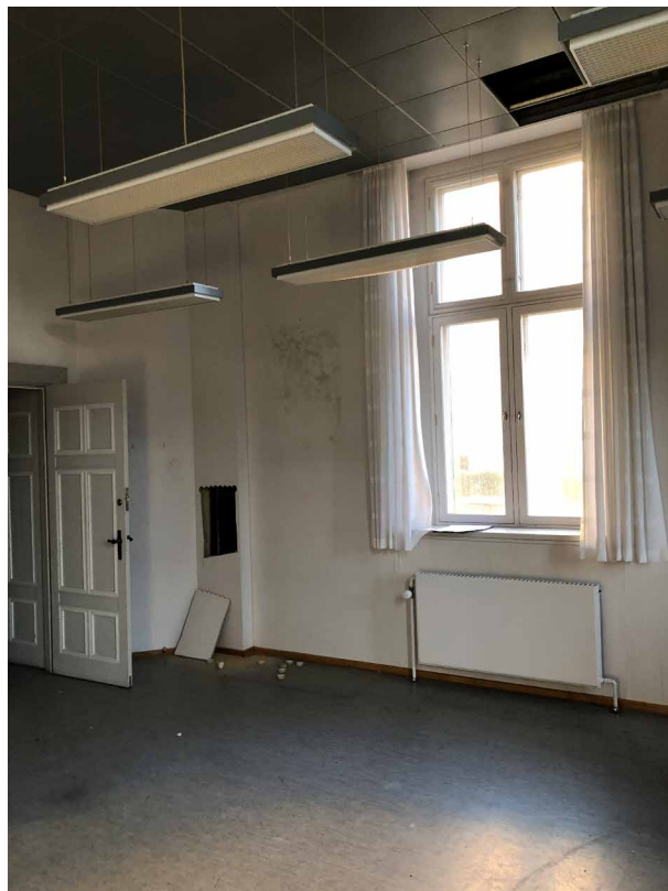
E.0.1 Nedhængt systemloft, linoleumsgulv og en formodet oprindelig dør.
