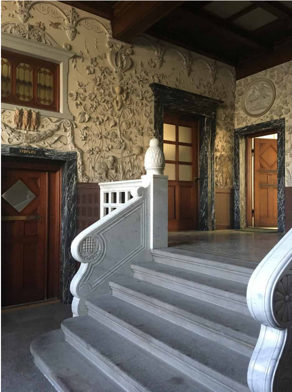
E.0.13 Vestibule dekoreret med fint bearbejdet granit, marmor, terrazzo, trædøre og stuk.
