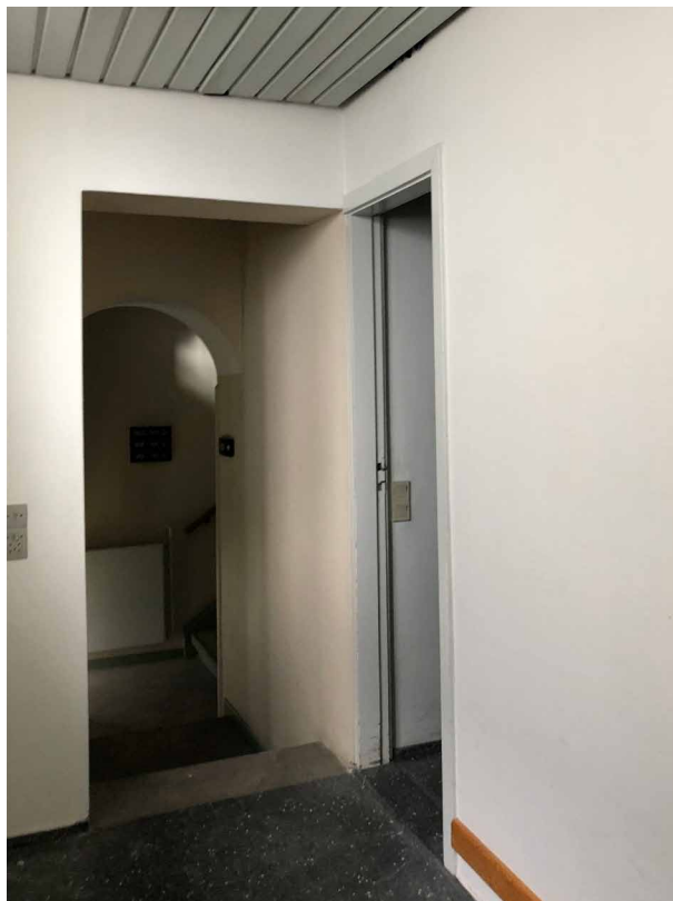
E.1.13 Ældre del af den kraftigt ombygget øvre mellembygning. Terrazzogulv, hvælv mod trapperum og nedhængt systemloft.
