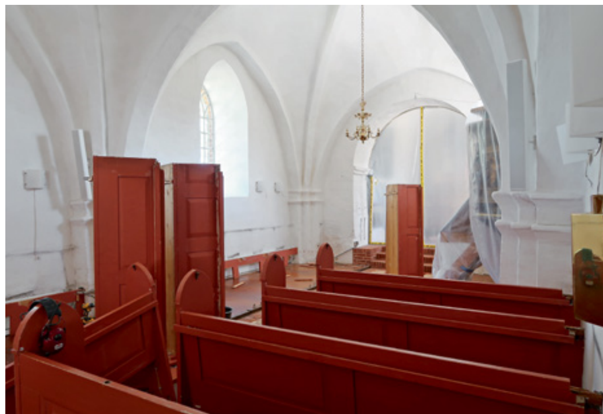
Kirken under renovering. Foto: Leif Hansen
