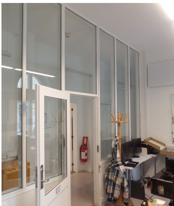
Stueetagen i Visitationsbygningen før ombygning med glasskillevægge
