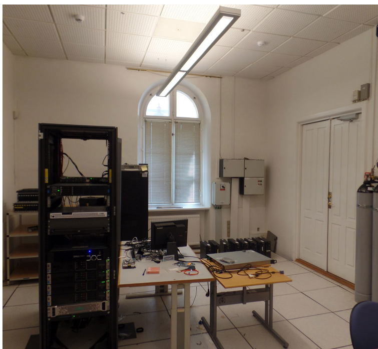
Serverrum i stueetagen i Visitationsbygningen før ombygning
