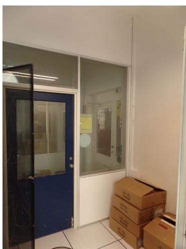
De små rum med skillevægge i stueetagen af Visitationsbygningen før ombygning
