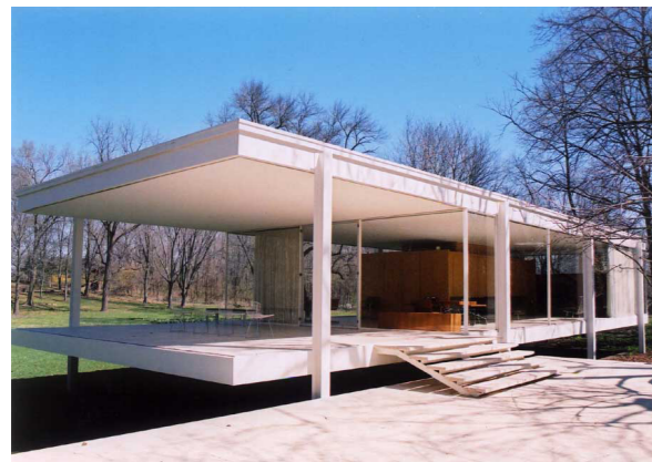
- DETALJE VED STERNKANT GØR BYGNINGEN MERE RAFINERET OG SPINKEL VED TAG KONSTRUKTION.
