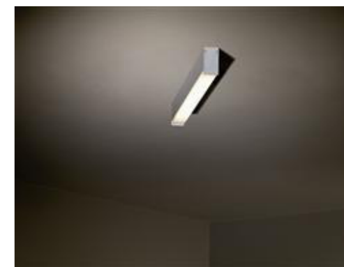
LYSARMATUR_PROFIL NEDHÆNGT I MØDERUM OG OVER KØKKEN Ø 2U PROFIL 49W_SORT ANTAL 2 STK_1500
