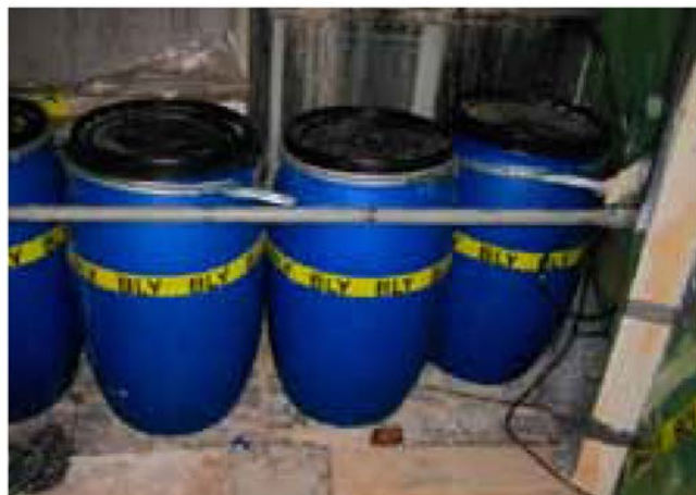
Opbevaring af blyholdigt affald i lukkede tønder/ fade med spændelåg – tydeligt mærket med 'BLY'
